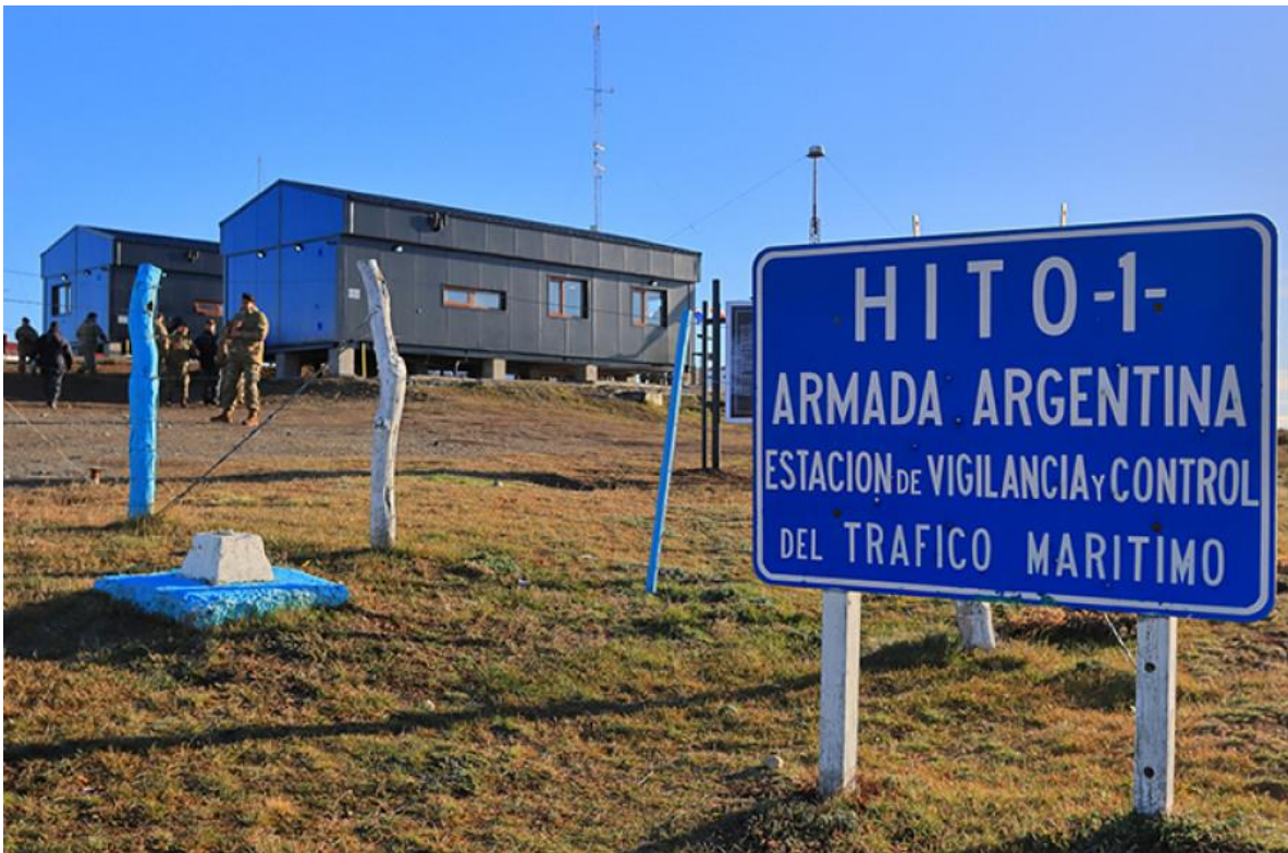
Estación de vigilancia y control de Puesto de Vigilancia y Control de Tránsito Marítimo Hito 1. (Armada Argentina)
